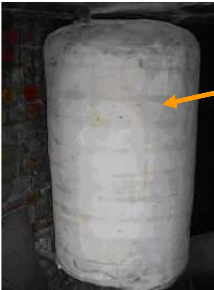
Calorifuge de ballon d'eau chaude
