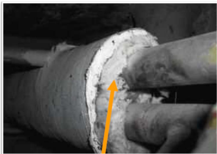
Calorifuge autour de tuyauterie
