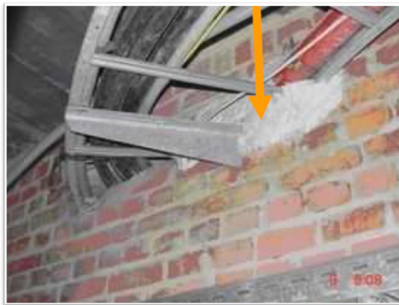
Bouffe d'amiante pour isoler un passage de câbles
